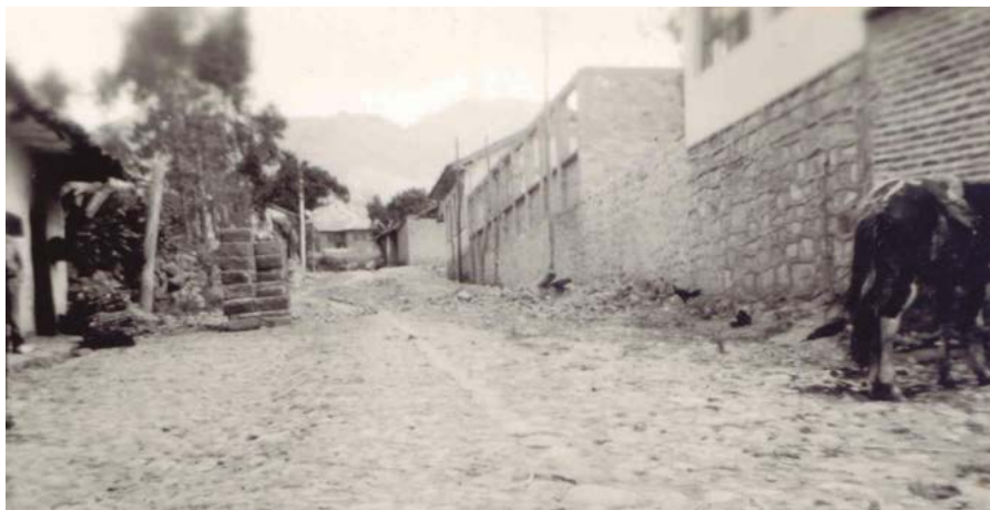
Construcción del pabellón de la escuela 27 de Febrero frente a la calle Córdova.
