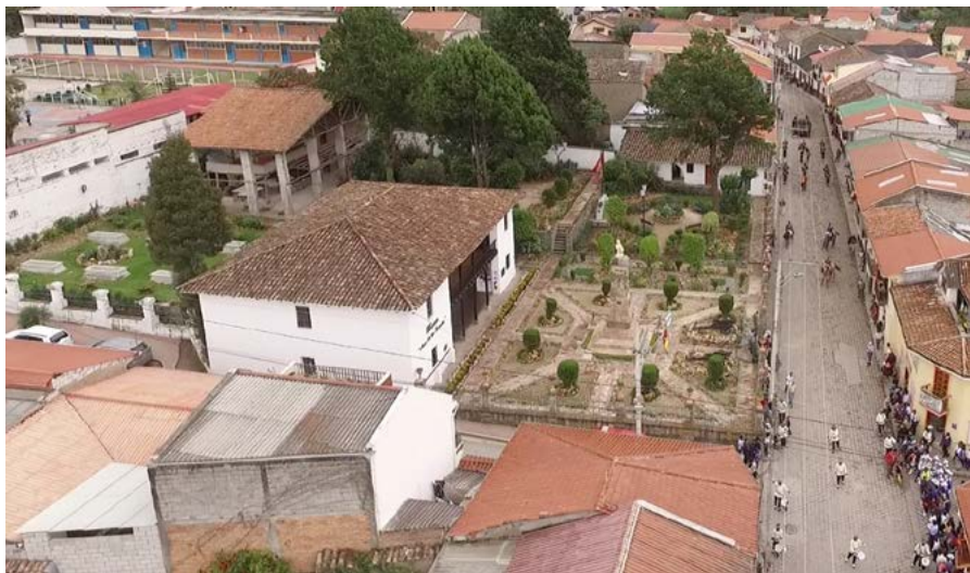
Vista aérea de los trabajos inconclusos tras de la casona del Museo Casa de los Tratados. Foto cortesía Efrén Monge.
