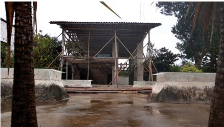
Estado actual de la edificación contigua al museo “Casa de los Tratados”
