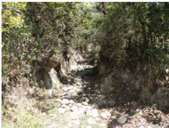
Sección del camino del tipo "colunco" pasado el tanque de agua.
