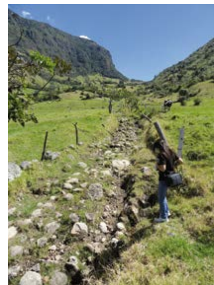
Camino a nivel superficial, con aparente empedrado y murete lateral izquierdo.
